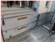
止水板の設置
