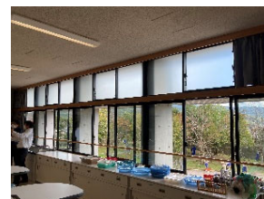
欄間窓のすりガラス
