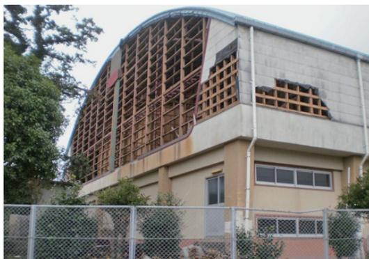
令和4年台風第14号で生じた体育館外壁の被害
