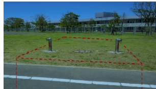
耐震性貯水槽
