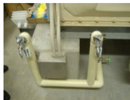
受水槽に蛇口を設置
