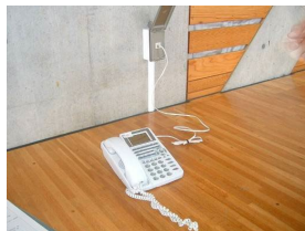
屋内運動場に 電話回線の設置
