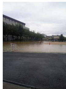
校庭貯留浸透施設（雨天時）
