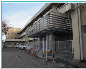
受変電設備の嵩上げ対策イメージ
