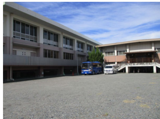
＜体育館・武道場ピロティ＞
