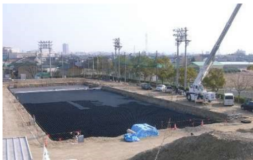
矢作北中学校 工事状況
