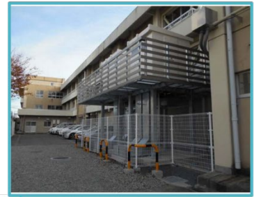
受変電設備の嵩上げ対策イメージ
