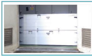
職員室への止水板設置イメージ
