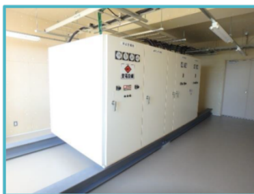
受変電設備の上階移設イメージ
