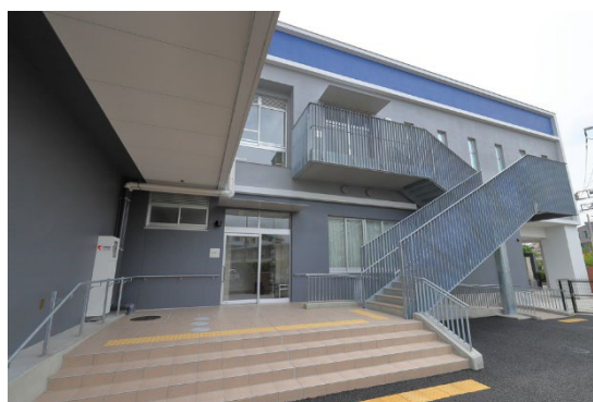
<体育館へ続く屋外階段>
