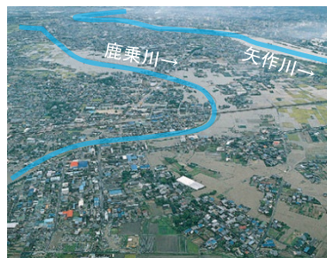
被災状況（平成 12 年東海豪雨）
