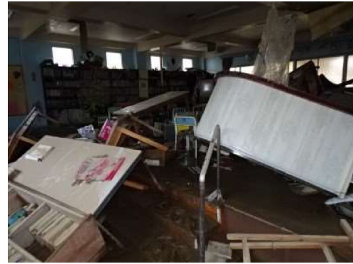
令和 2 年 7 月豪雨 図書室への床上浸水 ※学校再開まで1か月弱臨時休校
