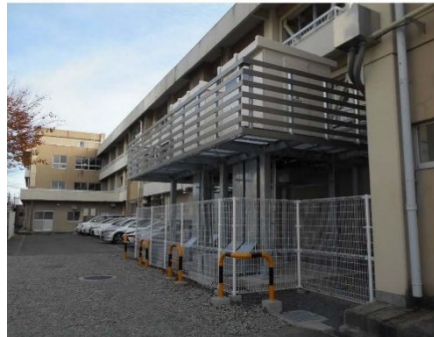
屋外キュービクルのかさ上げ
