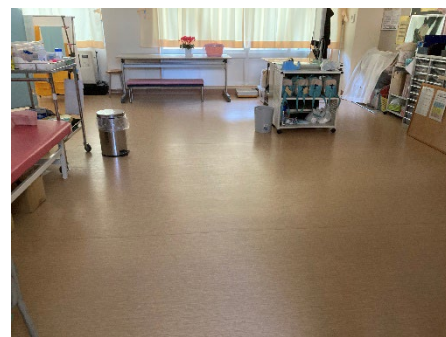
1階保健室の床ビニルシート
