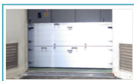
普通教室への止水板設置イメージ
