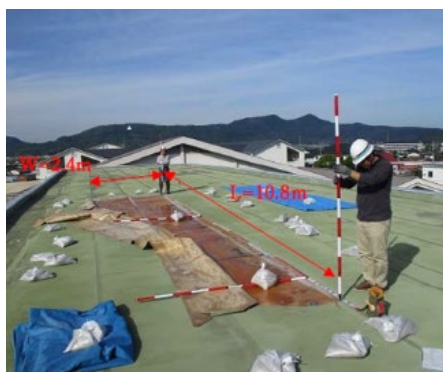
屋上防水シート被災箇所の計測(始点と終点)
