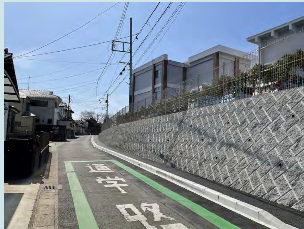
拡幅した道路と歩道
