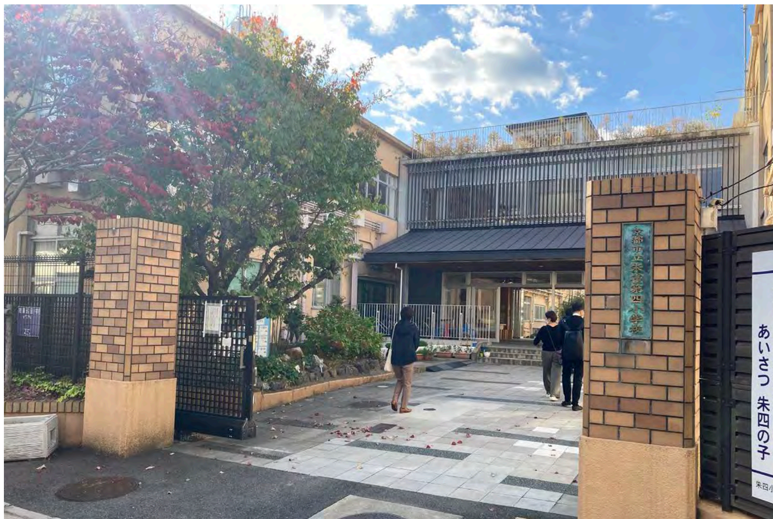
校舎外観（改修後）
