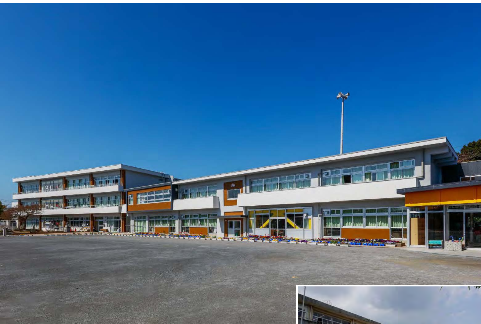
校舎外観（改修後）
