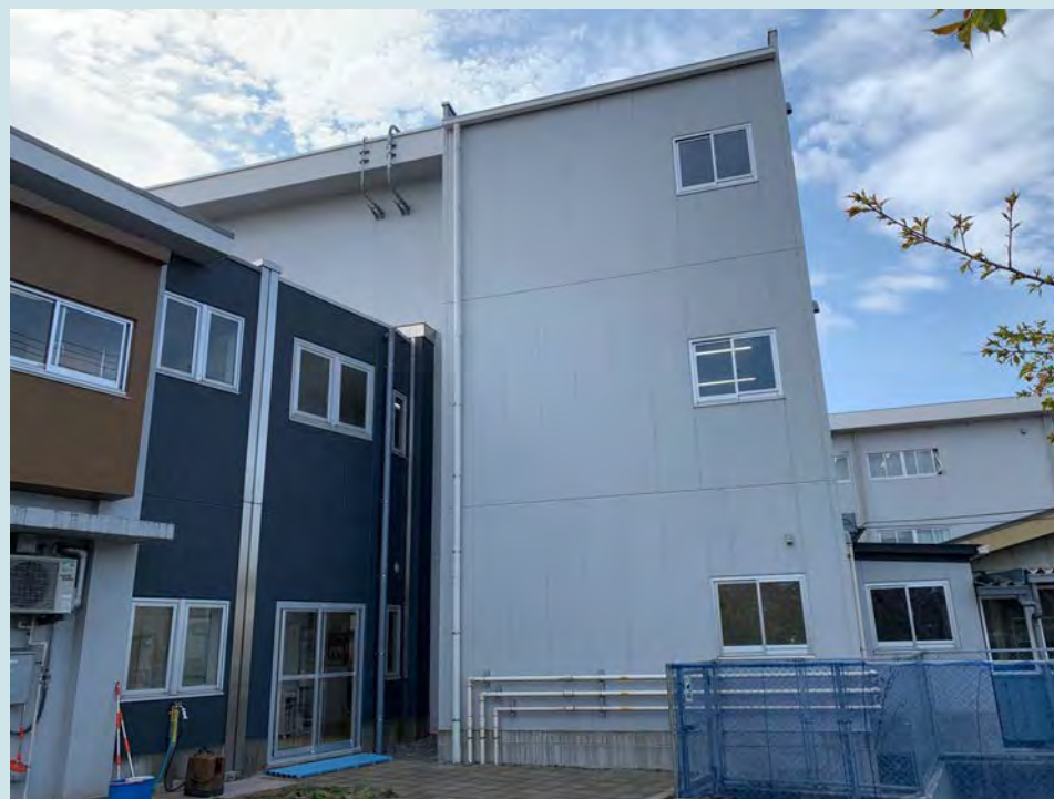
エレベータ増築部分外観
