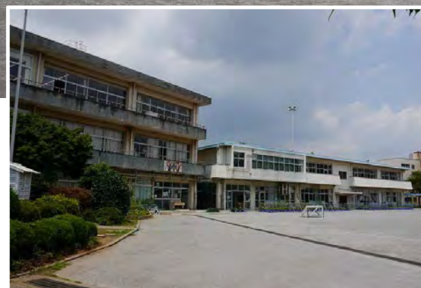
校舎外観（改修前）
