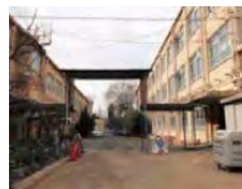
校舎外観（改修前）
