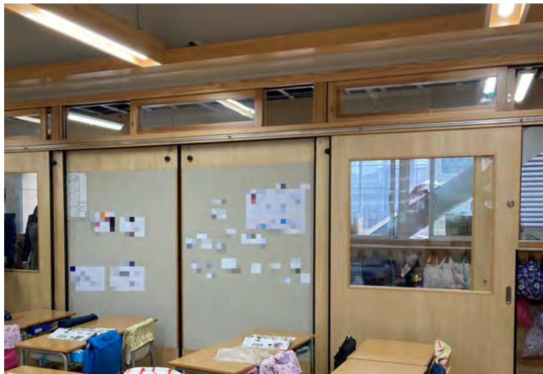
①普通教室・教室周りの機能向上（掲示板付きの間仕切り）
