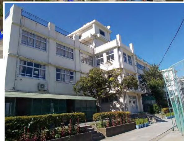
校舎外観（改修前）
