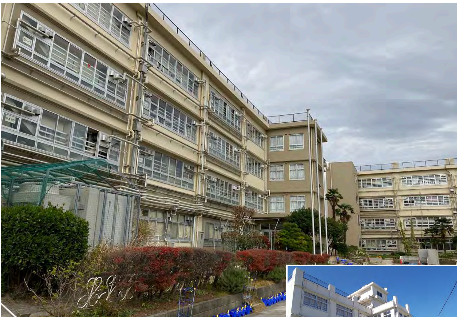
校舎外観（改修後）
