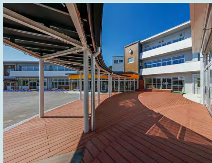
地域開放エリアと昇降口間の 渡り廊下とデッキ
