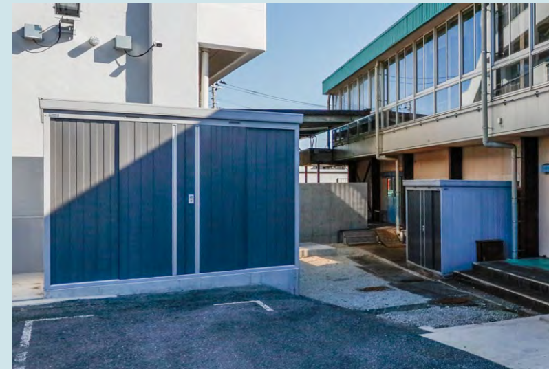
新設した倉庫（左）と改修後の倉庫（右奥）
