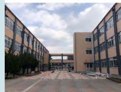
エレベーター棟の増築
