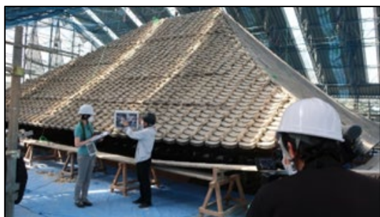
修理現場からのライブ配信(東大寺戒壇堂)
