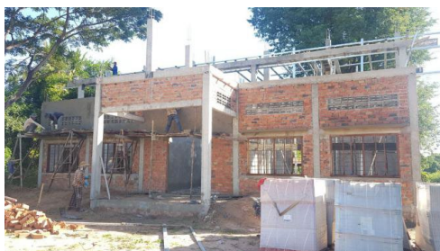
建設中のワリン寺子屋
