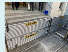
止水板の設置（給食室への浸水を防ぐ）
