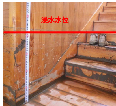
浸水水位の計測
