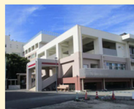
ピロティによる高床化
