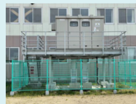
受変電設備のかさ上げ
