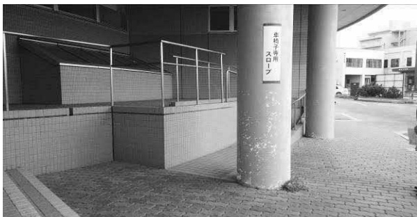
車椅子専用スロープが設置されている玄関
