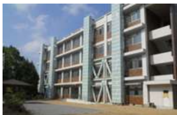
老朽改善された施設
