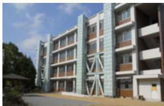
老朽改善された施設
