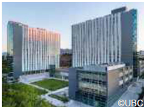
Orchard Commons 学生寮 外観
