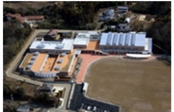
小学校の改修事業
