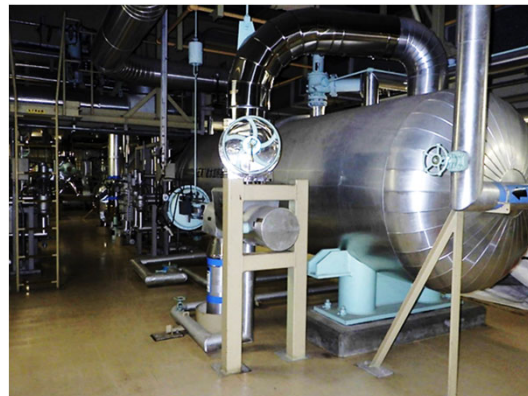
高圧給水加熱器
