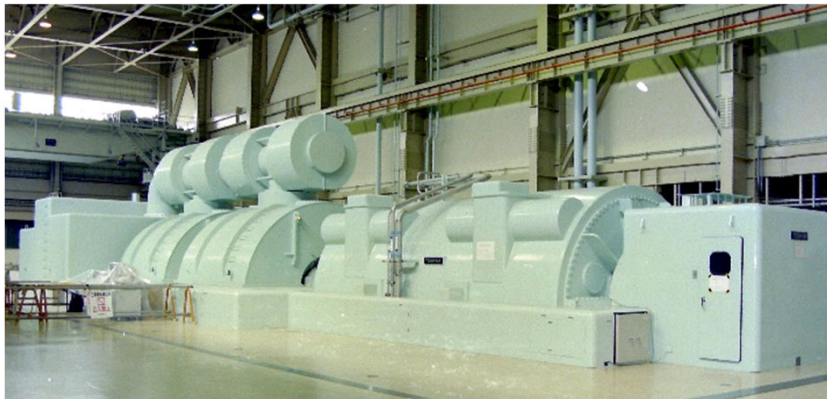
タービン発電機（タービン建物3階）
