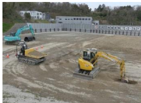
鹿島建設(株) 自動化施工技術
