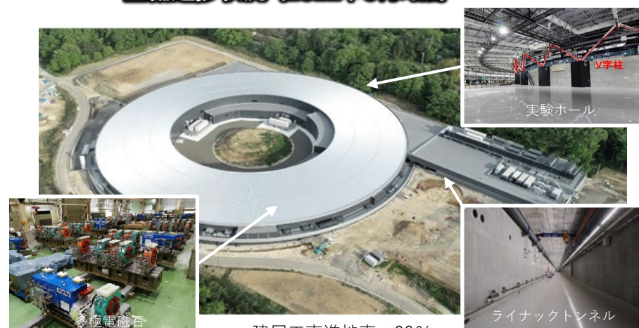
整備進捗状況 (2022年6月時点)
