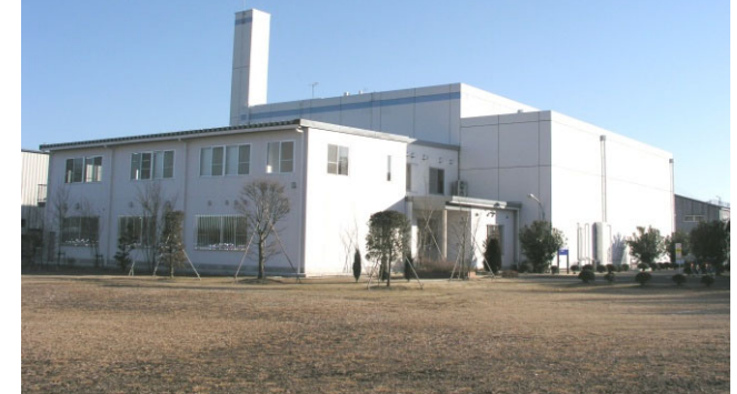
HTR 燃料製造施設 (1992年完成)
