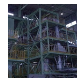
蒸気発生器安全性 総合試験装置 (SWAT-3R)
