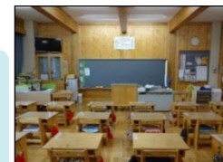
真庭市立北房小学校 普通教室 CLT部分利用 (構造材)
