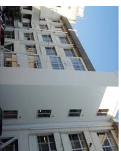
既存校舎に増築したエレベーター棟
