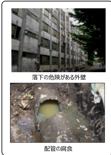
老朽化した施設・ライフライン
