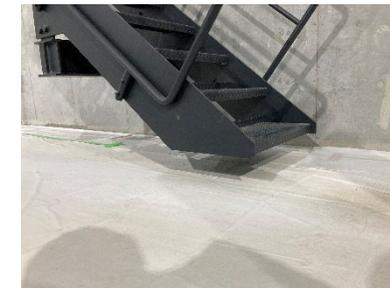
実験ホールのビームラインの設置はこれから。ビームラインへの機械振動ノイズを除去するため、階段は床に直接接していない。
