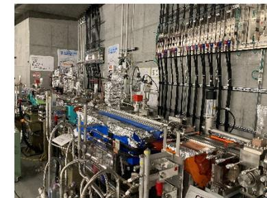
シンクロトロン加速器の電磁石は設置完了。電磁石を半割にして真空パイプの設置を行っている。
