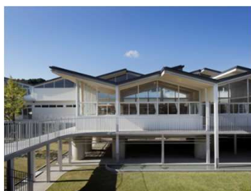
高床化による校舎への浸水対策
