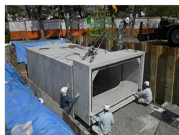
校庭の地下への雨水貯留槽の設置
