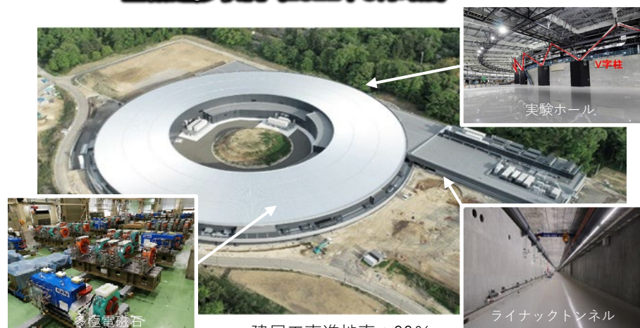
整備進捗状況 (2022年6月時点)
