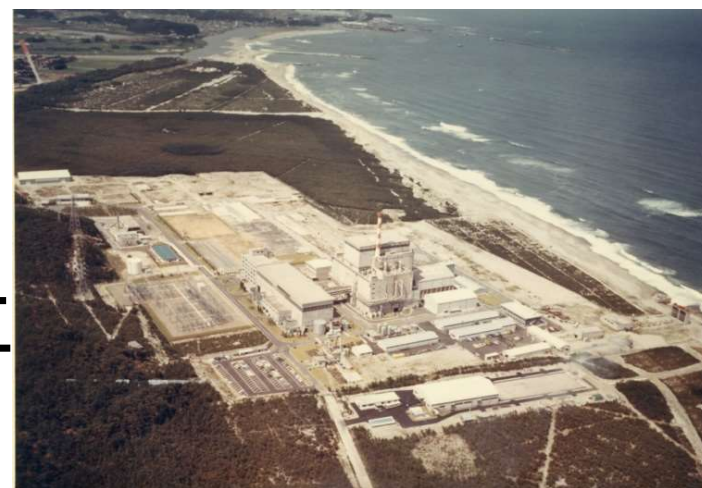
運転開始当時の東海発電所
