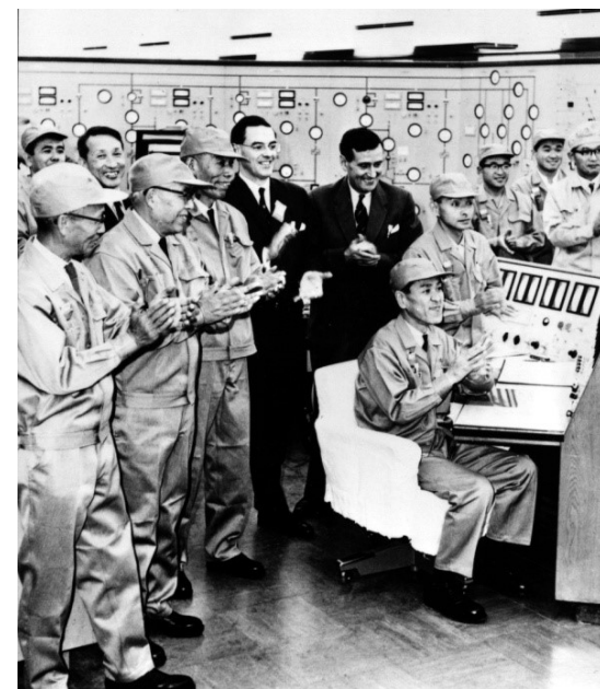
東海発電所初臨界(中央制御室)
