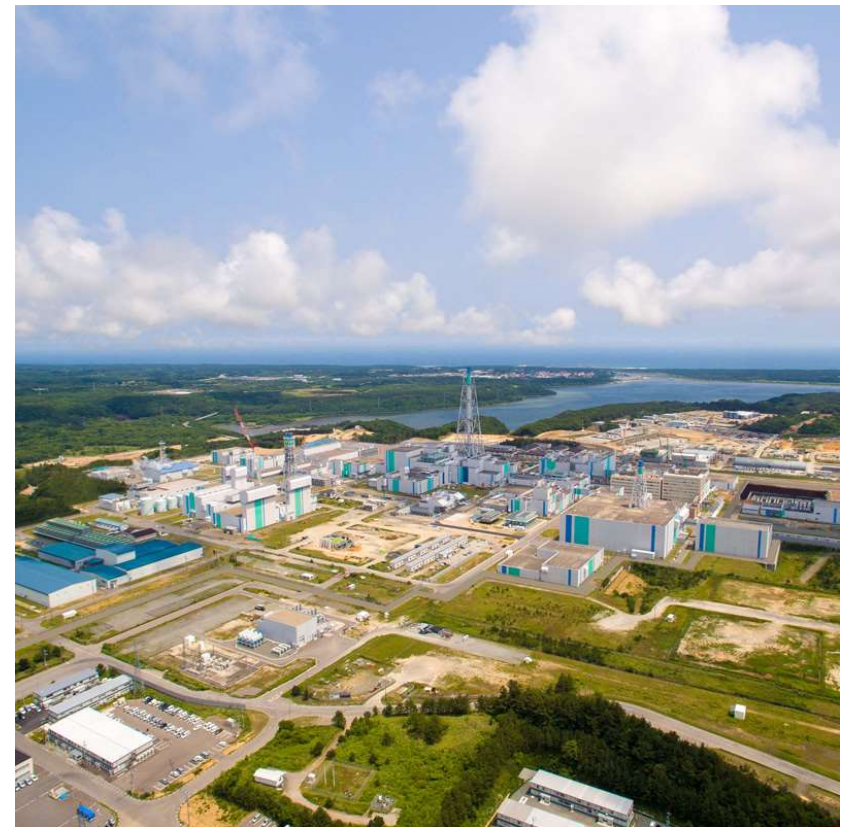
六ヶ所再処理施設全景
