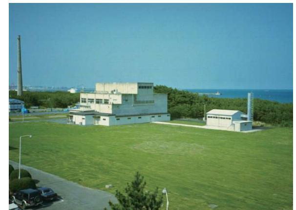
動力試験炉の解体前と解体後
