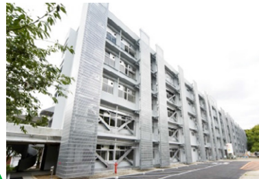
耐震補強と外壁の改修
