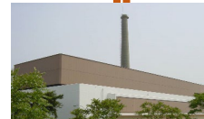
高レベル放射性物質取扱施設 (CPF)
