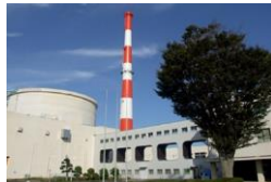
高速実験炉「常陽」
