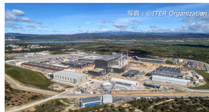
（令和4年6月時点・ITERサイト）
