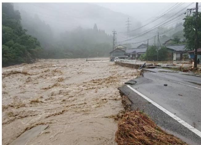
万江川の氾濫により滑落した県道
