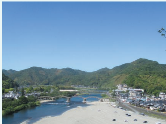
錦川下流域における錦帯橋と岩国城下町の文化的景観 (写真提供：岩国市)
