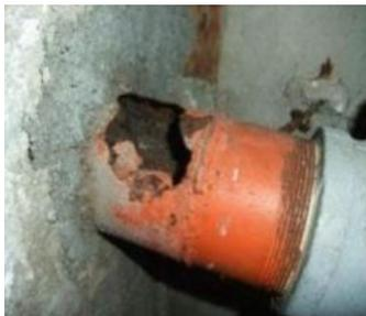
劣化による配管破損
