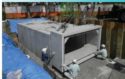
校庭地下に雨水貯留槽を設置し、短時間の局地的な大雨の際に、学校敷地内や近辺への雨水流出を抑制する
