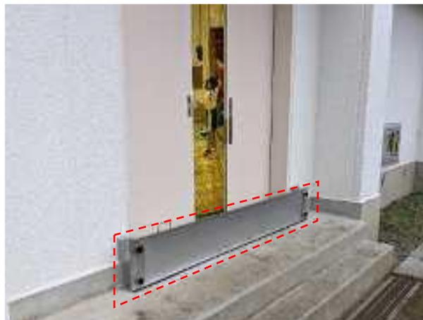
屋内運動場の出入口に設置された止水板
