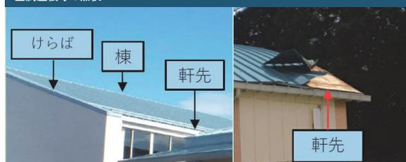
体育館等の金属屋根は、専門業者（製品供給業者、専門工事業者、設計事務所等）により、定期的な点検を実施することが重要。台風などの強風により金属屋根に被害がある場合、軒先・けらば・棟などに集中して被害が発生。
