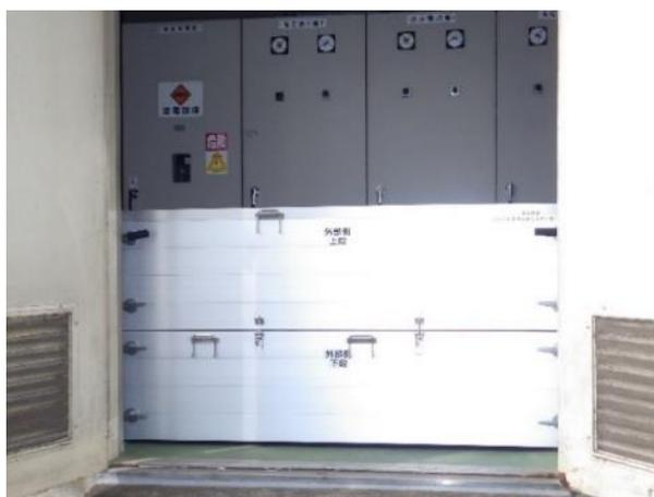
電気室の入口に設置された止水板
