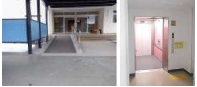
児童生徒の状況に合わせ、スロープを、勾配の小さいものに付け替え
