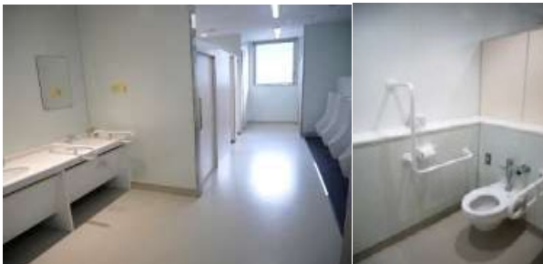
各階にある一般のトイレも広く作られ、その内部には、車いすでも利用できるトイレが整備
