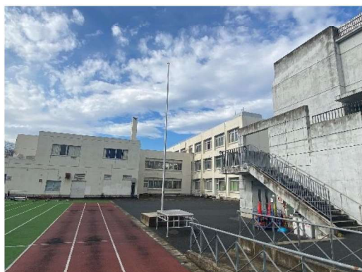
⑤ 外部 C 棟
