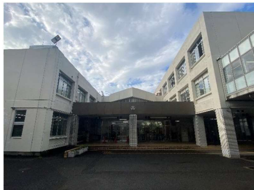
② A・B 棟間昇降口
