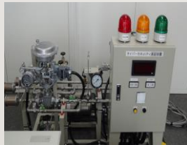
ガスプラント
