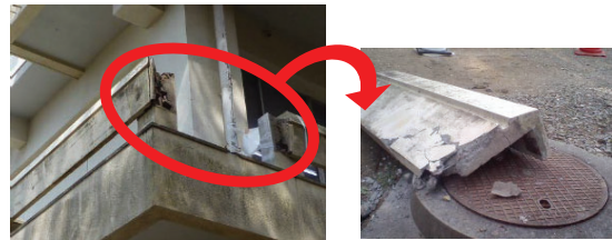
老朽化により手すりが落下
