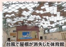
台風で屋根が消失した体育館
