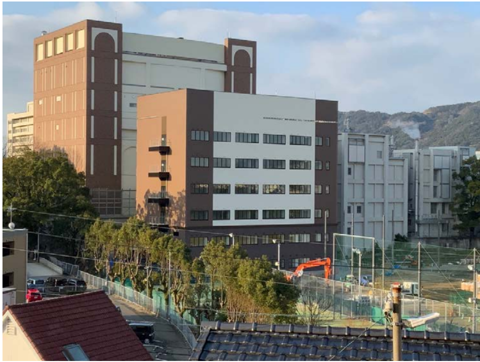
施工状況全景（2/24撮影）
