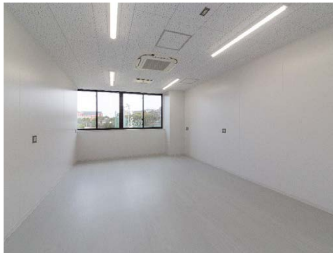
内装工事施工状況（3/7撮影）
