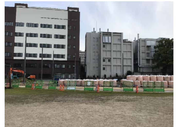
グランド復旧工事施工状況（3/7撮影）
