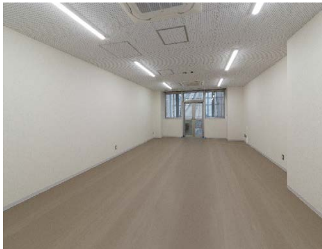
内装工事施工状況（3/7撮影）
