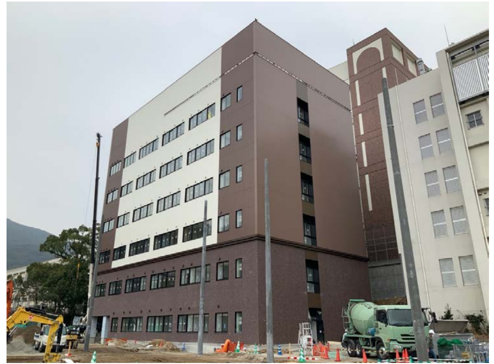
施工状況全景（2/24撮影）
