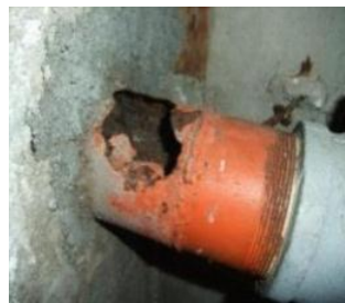
劣化による配管破損
