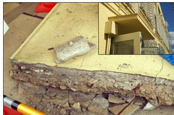
校舎出入口の庇（約800kg）が落下
