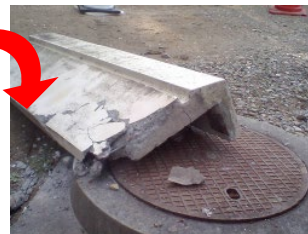
老朽化により手すりが落下
