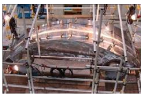
③モックアップ溶接試験
