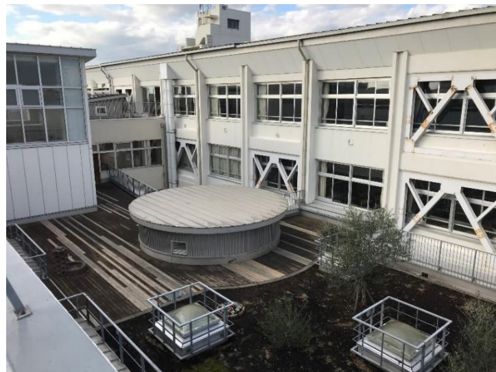
校舎外観（校舎間に増築）
