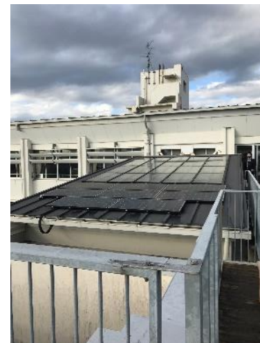
太陽光発電設備
