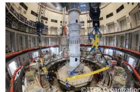
©ITER Organization (トカマクピットに据付けられるPFコイル)
