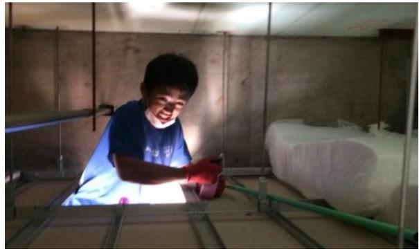
ウ 天井裏に設置する断熱材をカットしていく作業
