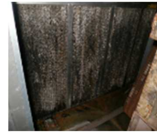
加湿器濾過材の整備
