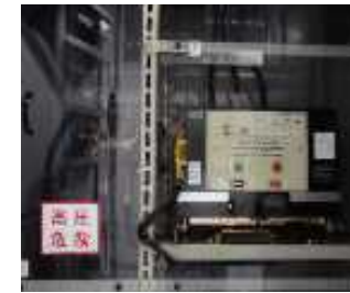
受配電設備の更新
