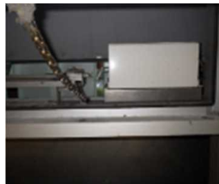
自然排煙設備の整備
