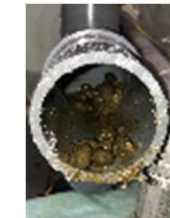
動物実験施設 排水管の 糞尿詰まり
