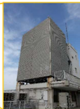
高架水槽の外観 (第1研究棟屋上)
