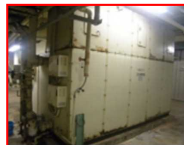
JT-60整流器棟空調機
