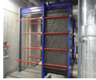
熱交換器の整備
