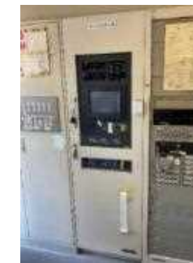
火災報知設備
