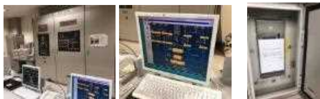
中央監視システム
