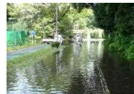
▲排水不良による構内冠水
