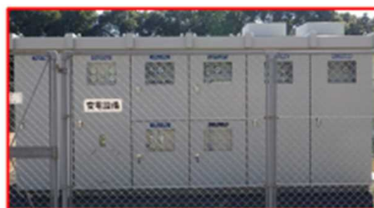
給水施設受変電施設
