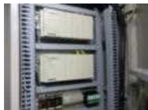
空調自動制御システムの更新
