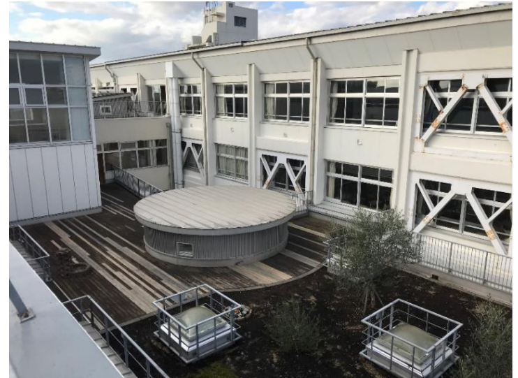
校舎外観（校舎間に増築）
