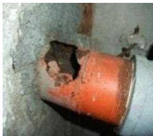
劣化による配管破損
