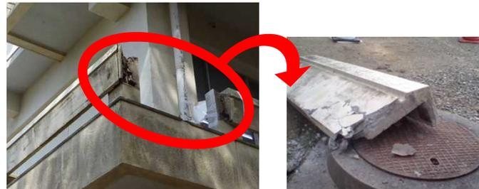
老朽化により手すりが落下
