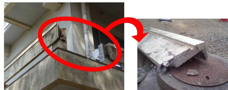
老朽化により手すりが落下
