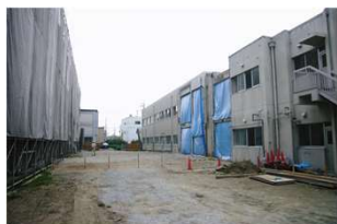
中庭：夏休みを利用して渡り廊下を撤去
