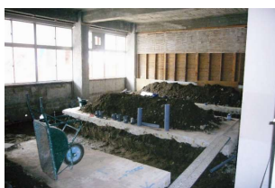
土間コンを部分撤去して配管を更新
