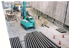
増築部：小型重機で施工できる鋼管杭を採用
