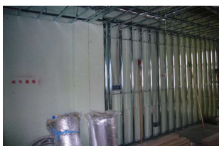
外壁の内側に断熱を施し内壁を起す
