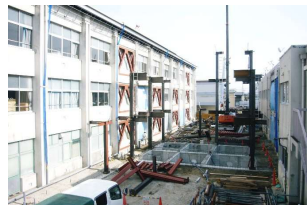
増築部：工場製作・工期短縮できるS造
