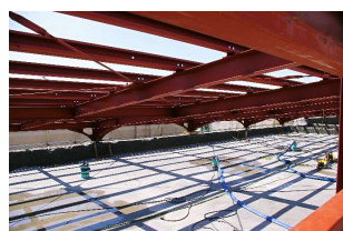
北校舎：押さえコンを撤去して軽量化
