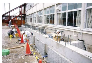
南校舎：アウトフレームによる耐震補強
