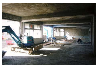
外装・躯体を残しスケルトンからの再構築
