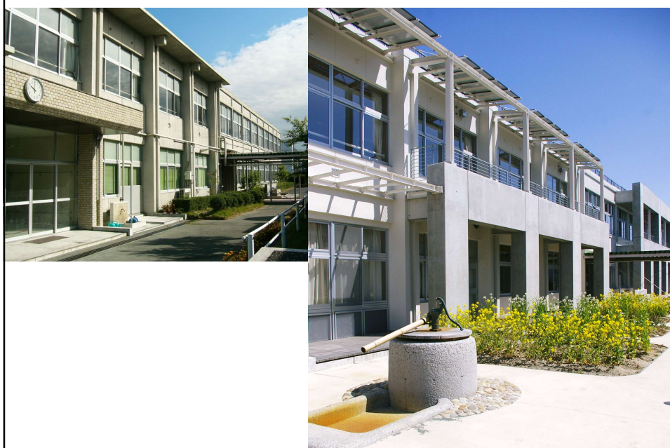
改修前後南校舎 通過動線から憩いの場へ
