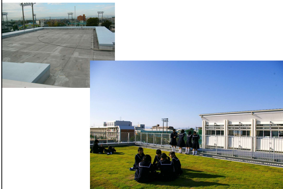
改修前後屋上 屋上緑化して有効活用
