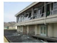
地震によりガラスが落下
