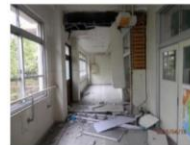
老朽化により天井や壁の一部が落下
