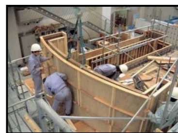
鉄筋コンクリート型枠施工実習
